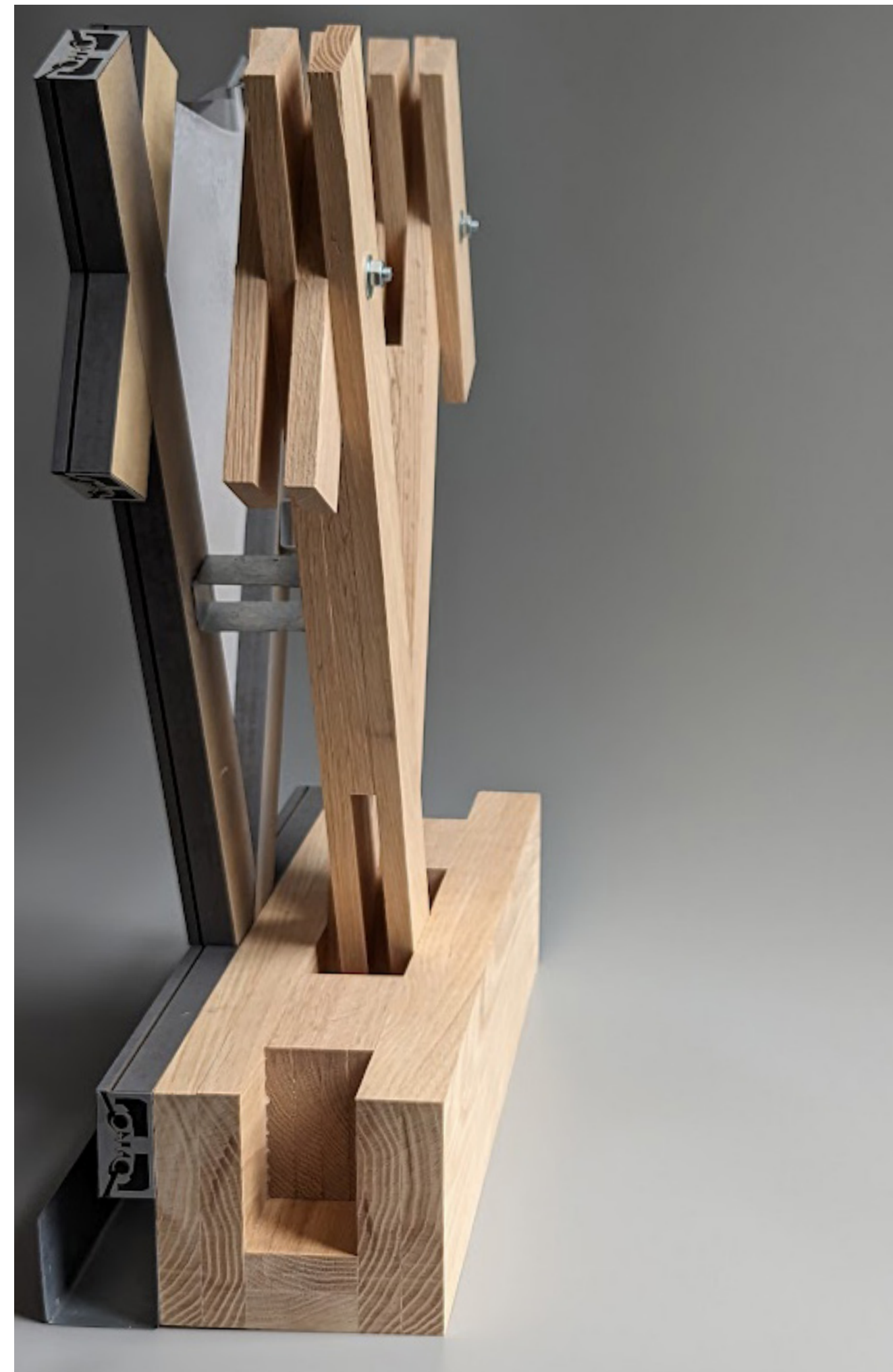
Maquette détail poutre «sandwich»
