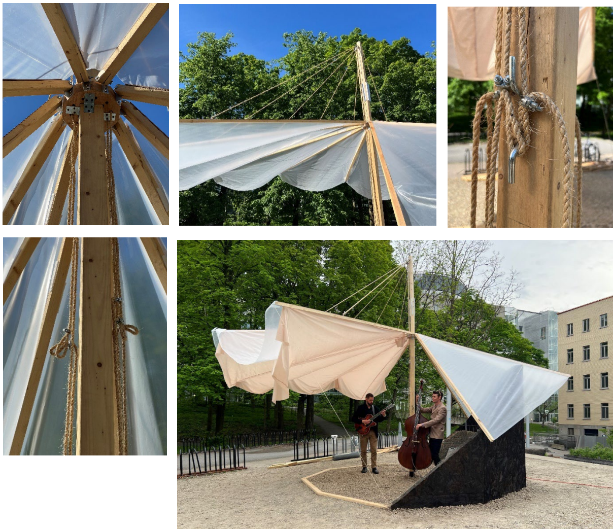
Figure 29 à 33 : Mécanisme d'ouverture
