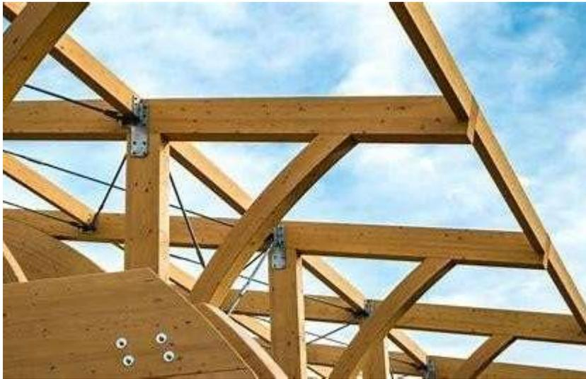
*Figure 1 : Ferme de toit en lamellé-collé*
