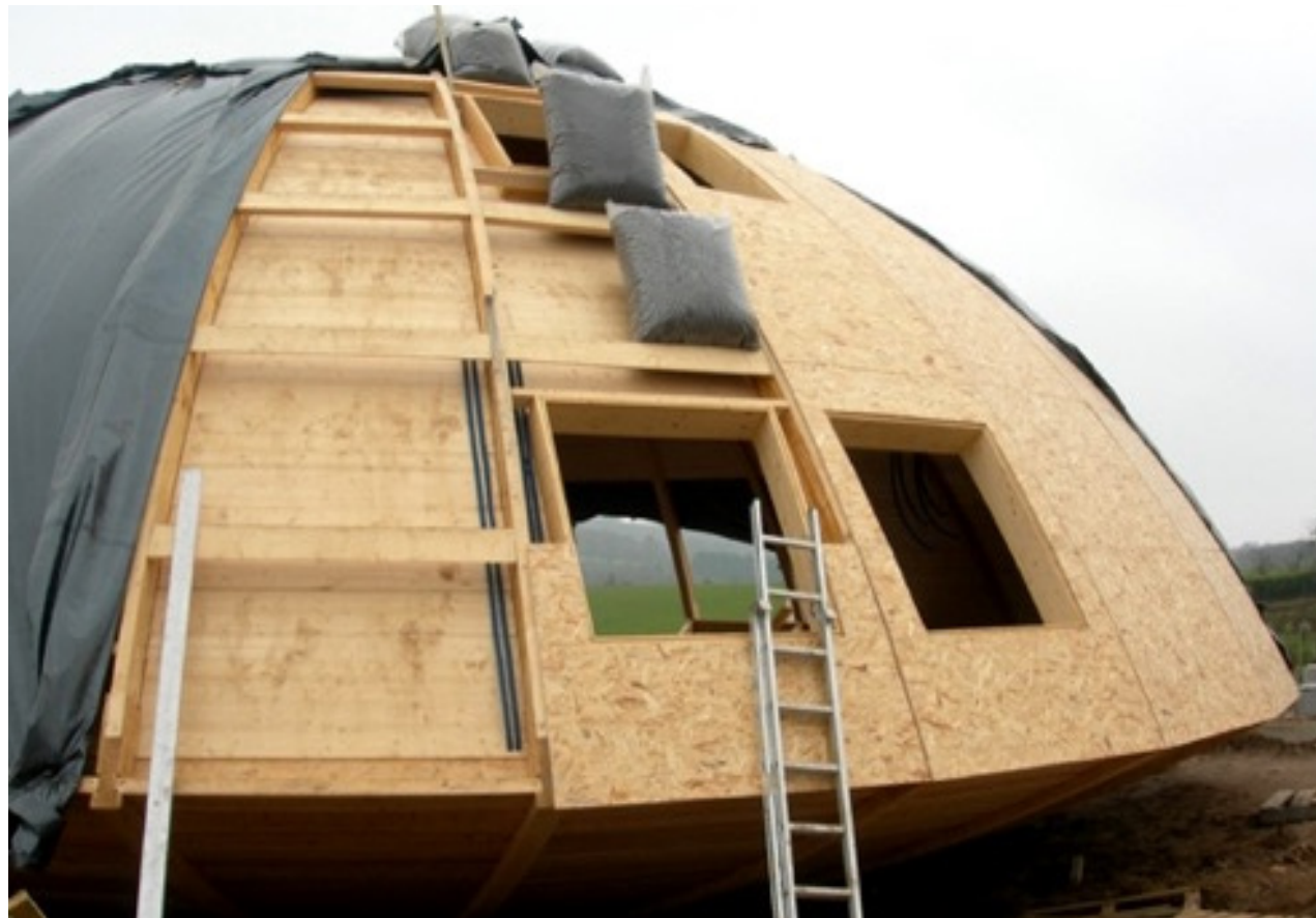
Assemblage des éléments préfabriqués
