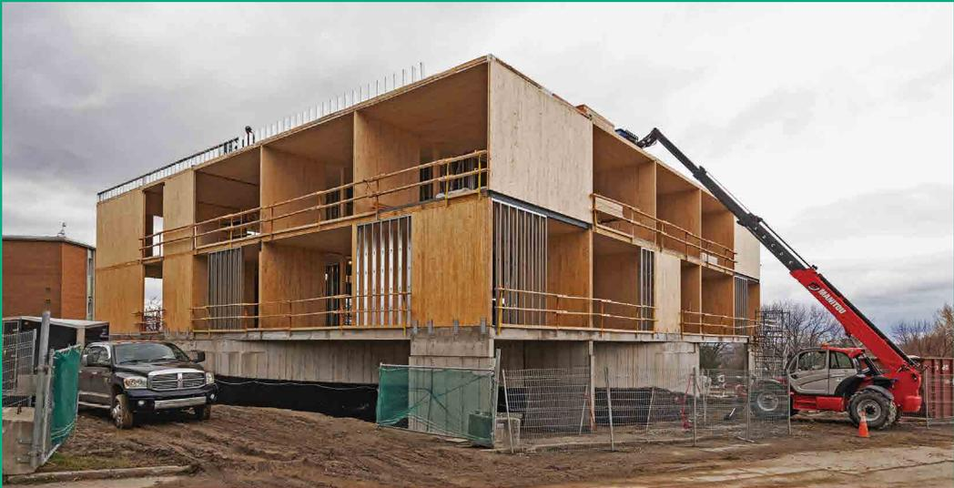
L'Institut Quantique, Université de Sherbrooke. Édifice de trois étages dont deux sont en bois massif (murs et dalles en CLT). La firme Latéral a collaboré pour développer des connexions avec tiges encollées dans le bois lamellé-croisé.
