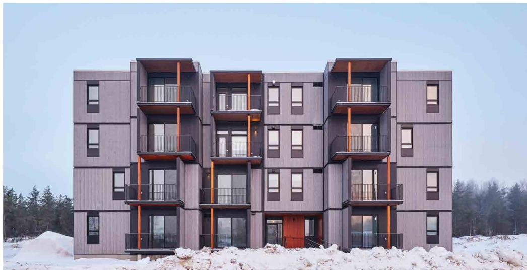
Les Pavillons du 49°, ensemble résidentiel érigé à Chibougamau réalisé à partir de 47 modules préfabriqués et assemblés en seulement quatre jours.
